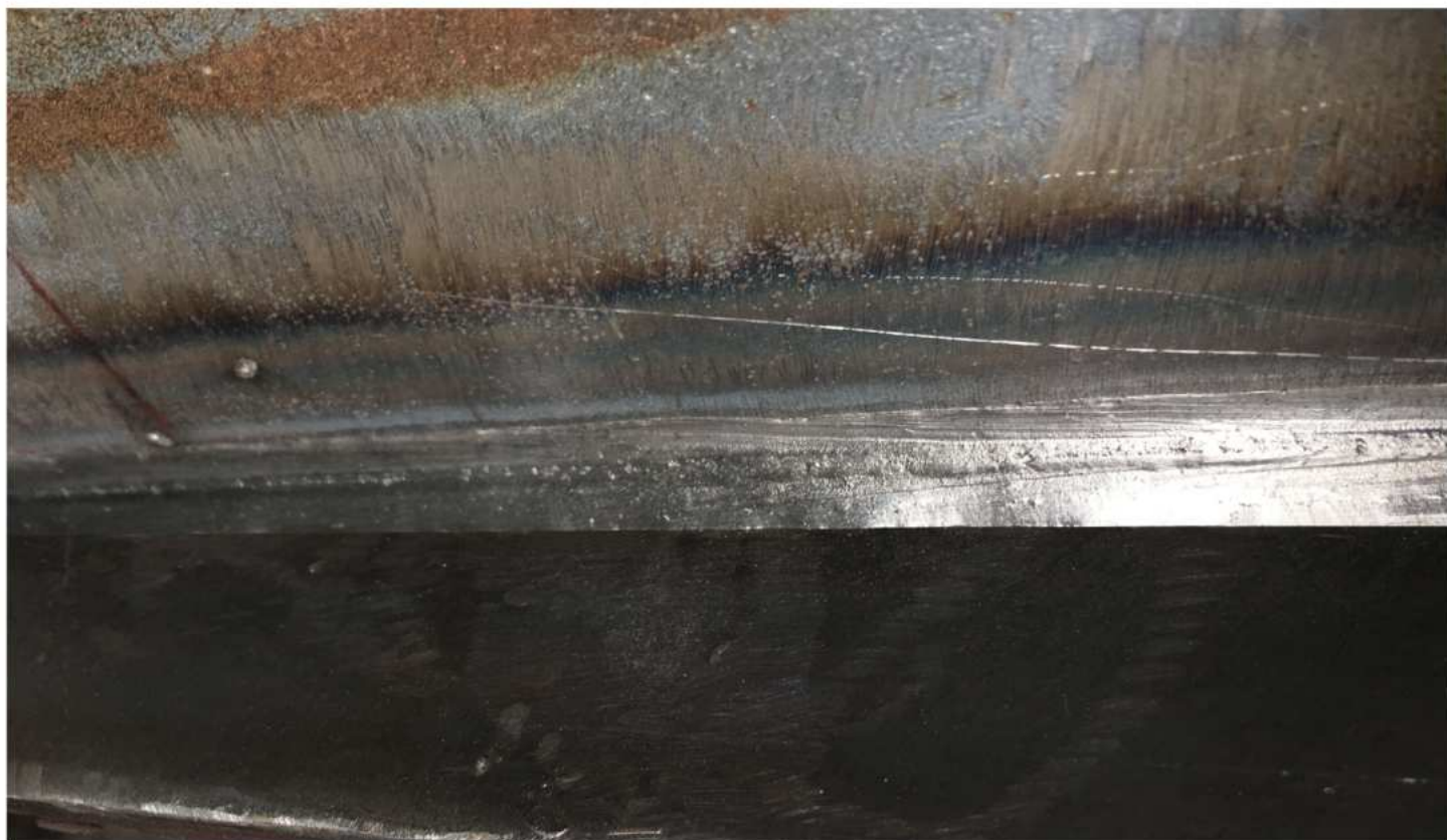
▲ UFB法焊缝照片（看面是外角焊缝）
