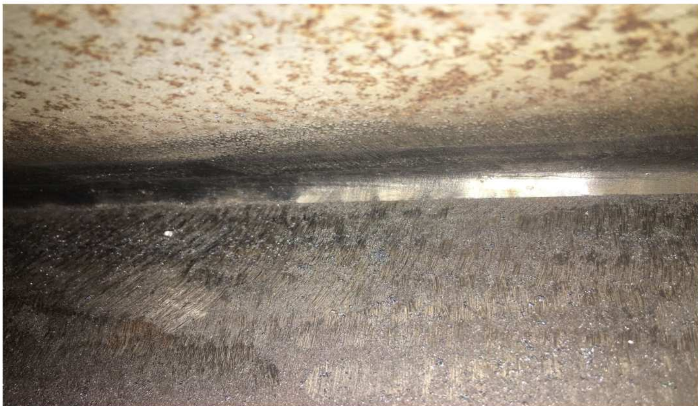
▲ UFB法焊缝照片（看面是内角根部焊缝）
